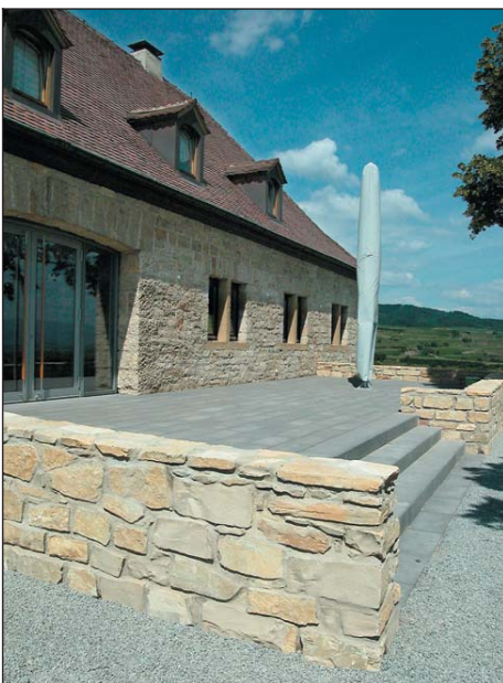
Die neu angelegte Terrasse lädt zum Verweilen ein. Hier befindet sich nun auch der Eingang zu den umgestalteten Verkaufs- und Präsentationsräumen.
